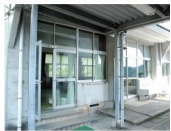
④ 図工室外観。
