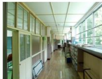
⑨3F 廊下。備付けの棚は書庫として利用。
