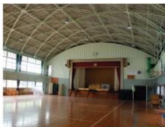
①屋内運動場。ステージ・控室あり。
