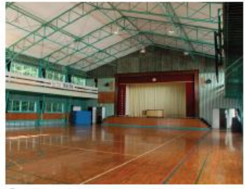
⑤ 屋内運動場。ステージと控入室がある。
