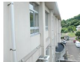
①建物外観と駐車場。
