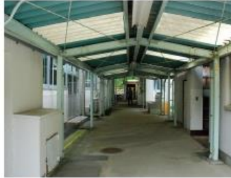
⑦管理員室、配膳室、資料室の並び。
