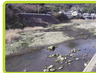
相浦川下流 (相浦支所付近)
