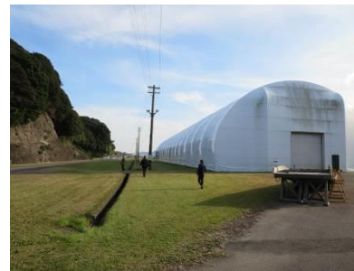
⑥倉庫(右の白いドーム)
