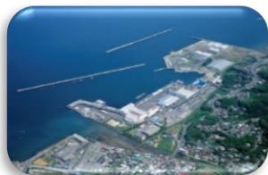
松浦火力発電所
