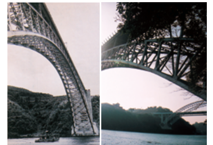
完成時の西海橋
