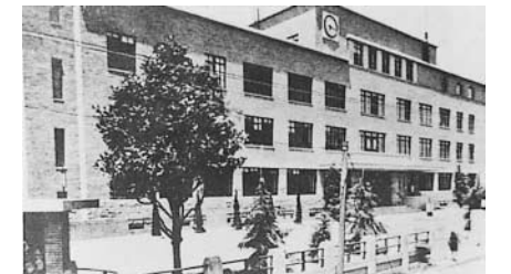
2代目(昭和9年建設)
