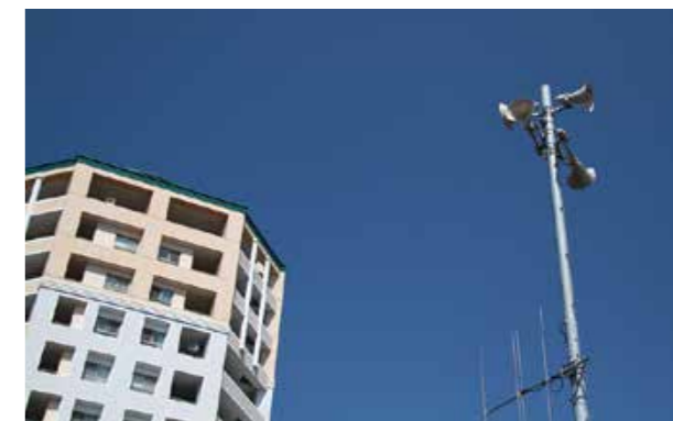
防災行政無線子局の拡声スピーカー。放送が届く範囲は1基当たり半径約300m。現在、市内に551基を設置
