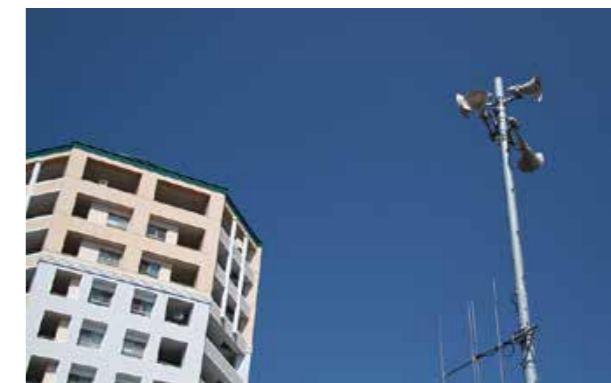
防災行政無線子局の拡声スピーカー。放送が届く範囲は1基当たり半径約300m。現在、市内に551基を設置
