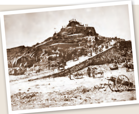
金比良山の切り崩し 切り崩しには火薬(地雷火)も使われましたが、まだ機械もなく人力だけで行われていました
