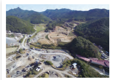
現在の石木ダム建設事業の様子
