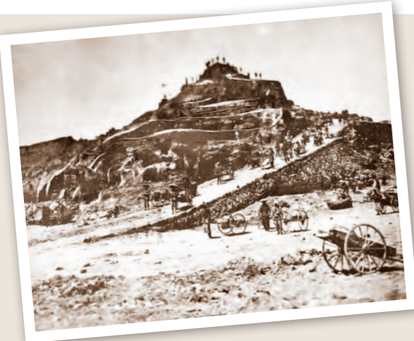
金比良山の切り崩し 切り崩しには火薬（地雷火）も使われましたが、まだ機械もなく人力だけで行われていました
