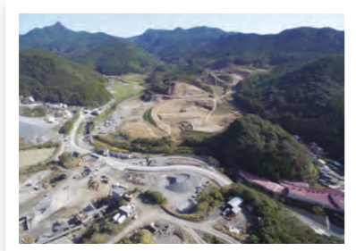
現在の石木ダム建設事業の様子
