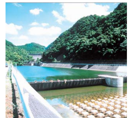
小森川取水安定施設
