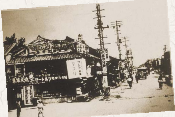
拡張(かくちょう)工事前の三浦町(戸尾町交差点付近)
