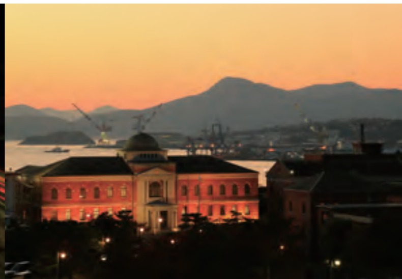
呉市・海上自衛隊呉地方総監部第一庁舎(旧呉鎮守府庁舎)
