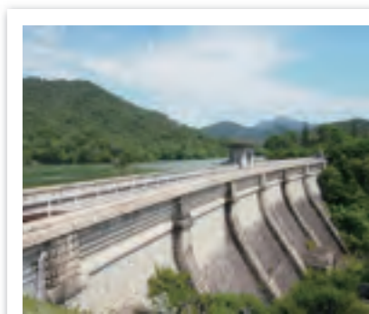
呉市・本庄水源地堰堤水道施設
