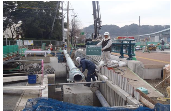
【街路改良工事に伴う配水管移設工事】
