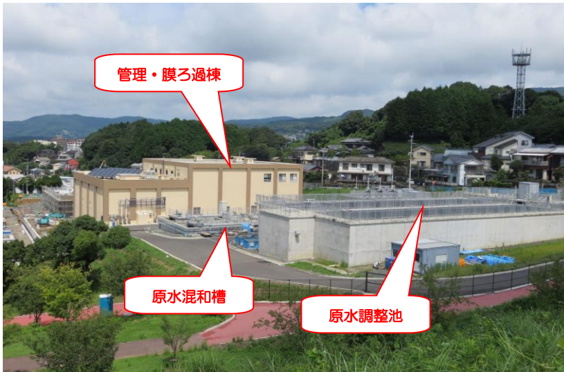
【建設工事の現況】（山の田貯水池より撮影）
