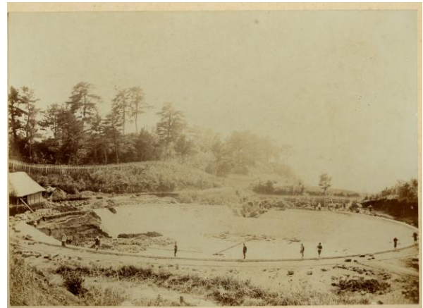
第 2 貯水池建設の様子(明治 33 年ごろ)
