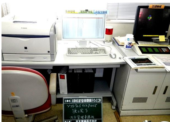
【北部地区遠方監視装置整備（その4）工事】
