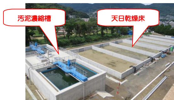
（管理・膜ろ過棟屋上より撮影）
