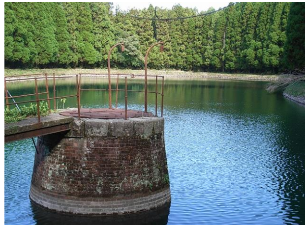
第 1 貯水池取水塔
