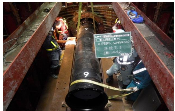
【干尽町周辺配水本管布設（その6）工事】
