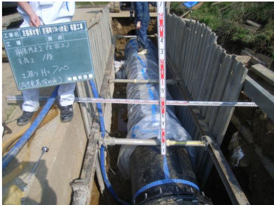
【吉福導水管布設工事】
