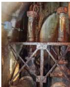
《川谷ダムの取水設備》
