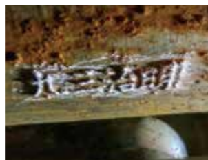
《取水設備の刻印》 明治39年に造られた物を 現在も使用している。
