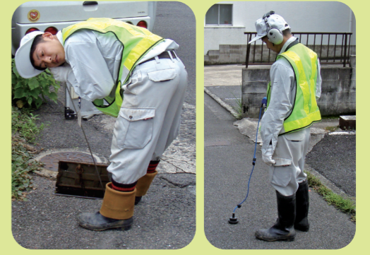
漏水調査の様子
