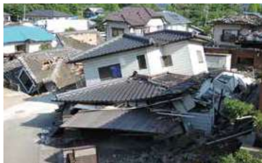
地震による被害例（熊本地震）
