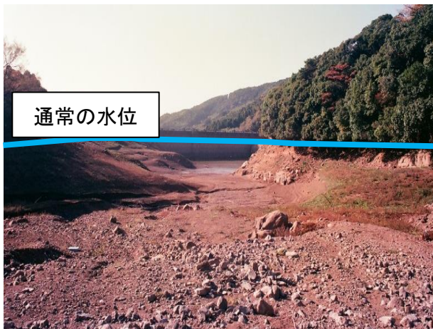
〔平成 6 年の相当ダム（柚木地区）の様子〕
