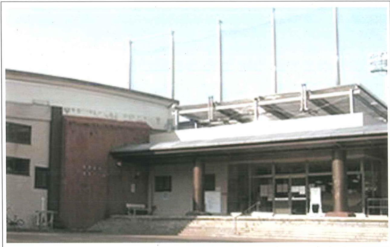
温水プール（外観）
