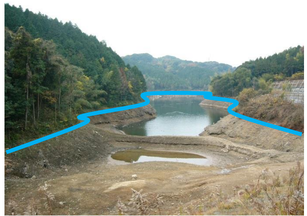
〔平成 19 年の下の原ダムの様子〕
