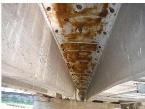
〔老朽が著しい相浦橋（補修前）の状況〕
