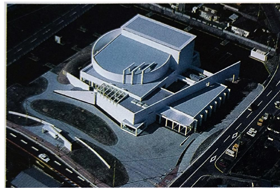
江迎地区文化会館「インフィニタス」(上空写真)
