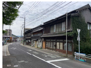
古民家の例：江迎地区
