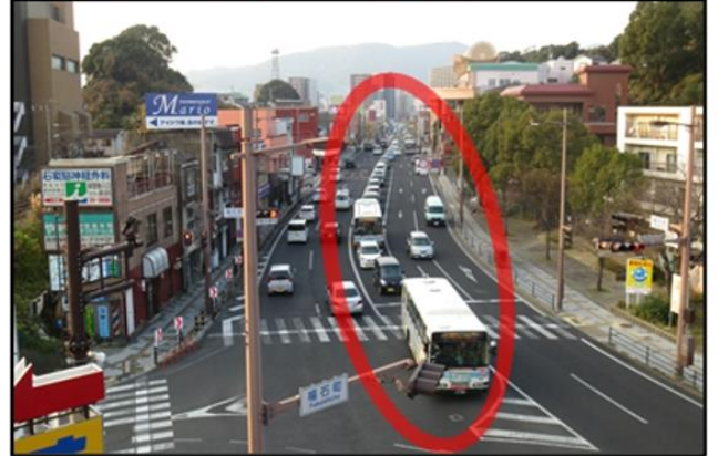
○右折車の滞留による通行阻害
