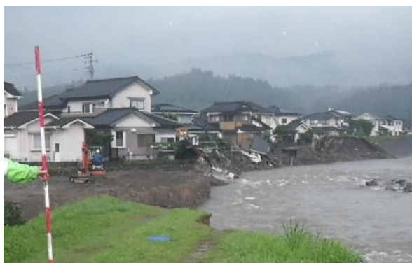
河岸侵食による家屋の倒壊(花月川)
