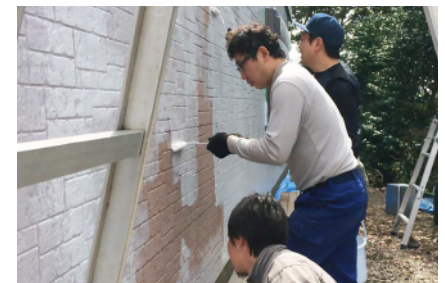
地域住民が参加したDIYによる施工も。
