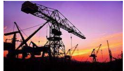
写真 11 250 トン重機クレーン
