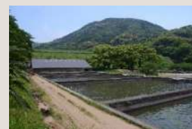
山ノ田水源地
