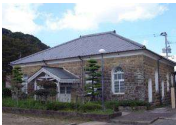
写真3 世知原地区炭鉱資料館
