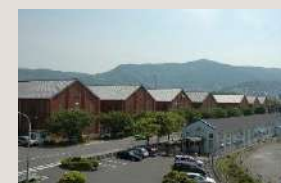
平瀬の煉瓦倉庫
