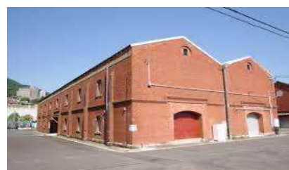
写真 12 立神地区の煉瓦倉庫群
