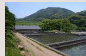
山ノ田水源地
