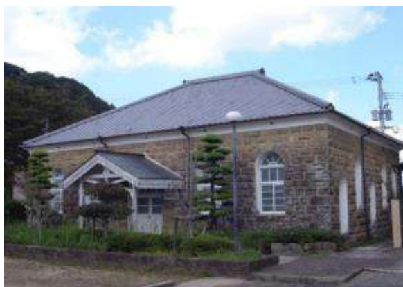
写真3 世知原地区炭鉱資料館
