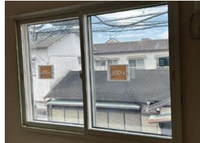
主居室の南側に内窓設置
