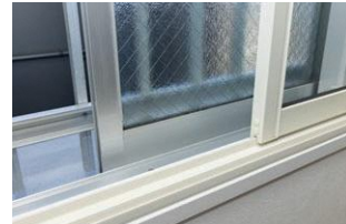
全住戸の内窓設置を実施
