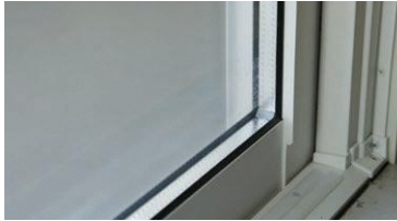
全住戸で外窓交換を実施
