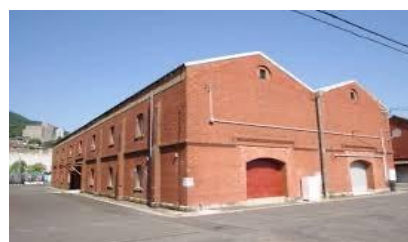
写真 12 立神地区の煉瓦倉庫群
