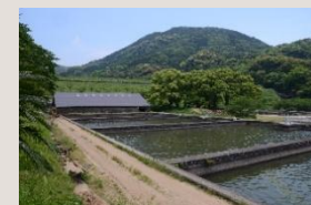
山ノ田水源地
