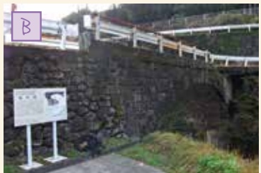
春明橋 架橋：大正 11 年(1922) 橋長：18.6m 佐世保市指定有形文化財
