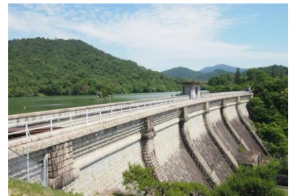
呉市本庄水源地堰堤水道施設 1920 年
