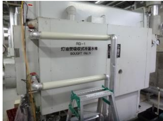
冷温水発生機の仕組み
