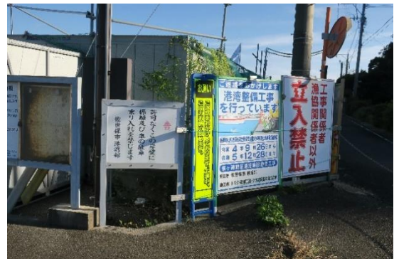
写真-10 安全看板（道路面部）
