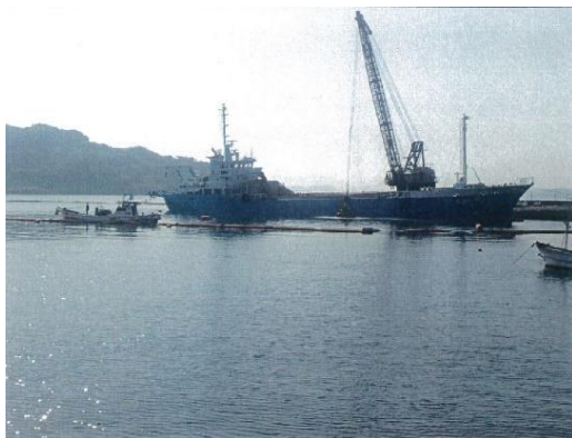
写真一3 基礎工 捨石投入状況 無規格
