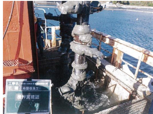
写真一2 深層混合処理 攪拌翼確認
