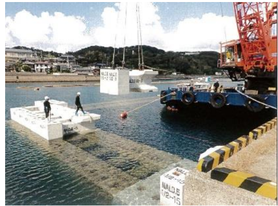
写真-6 本体内 ブロック据付
