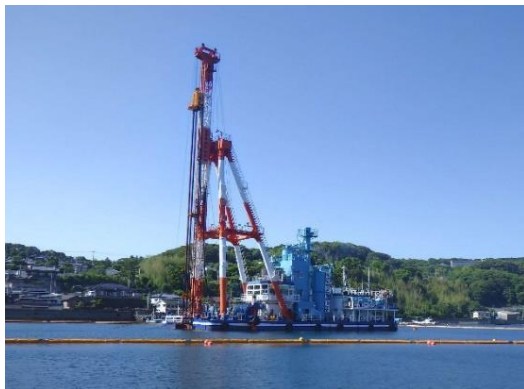
写真一1 地盤改良工 深層混合処理
