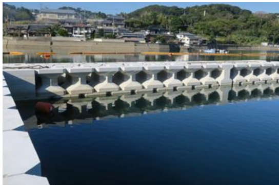
写真-7 本体内 直立消波ブロック
