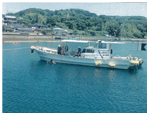
写真一4 基礎工 本均し 潜水土
