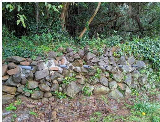
水抜きボーリング (1 工区)
