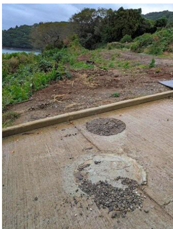
鋼管杭施工完了箇所
