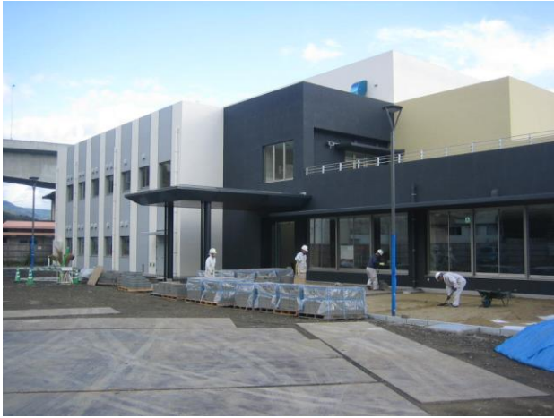
写真-1 建物北側外観 (外構工事中)
