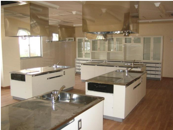
写真-3 1階調理実習室仕上り状況
