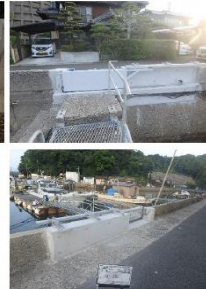
引戸式ゲート設置
