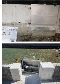
片開式ゲート設置
