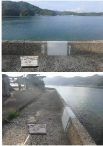
コンクリート閉鎖
