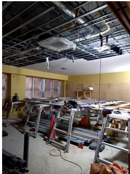
写真 8－改築棟 1 階内部工事
