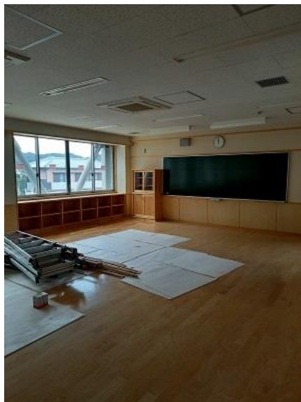
写真 4ー普通教室(改修棟)
