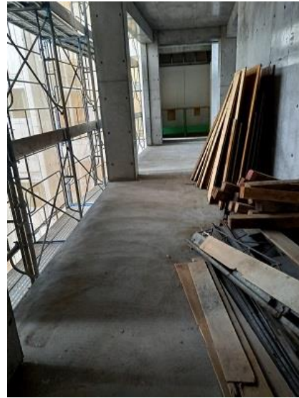
写真 10－床端部落下養生
