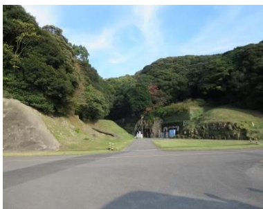
④弾薬庫(トンネル式)遠景
