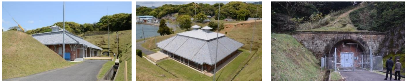
建造物式の弾薬庫（第六下瀬火薬庫及び周辺）
