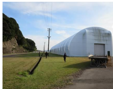
⑥バックゲート付近 b [右：テント小屋（倉庫）]
