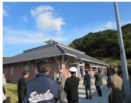
④弾薬庫パゴタ式外観
