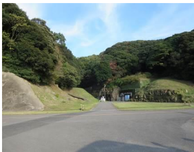
④弾薬庫(トンネル式)遠景
