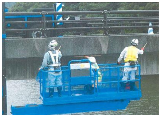
橋梁点検状況
