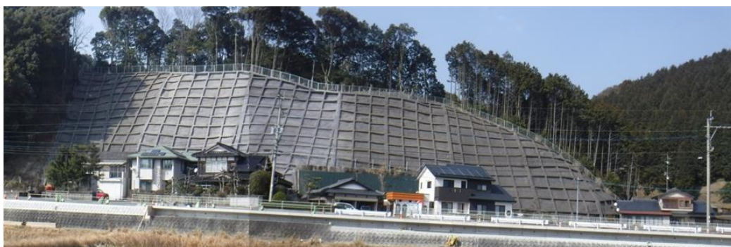
急傾斜地崩壊対策事業（対策完了）
