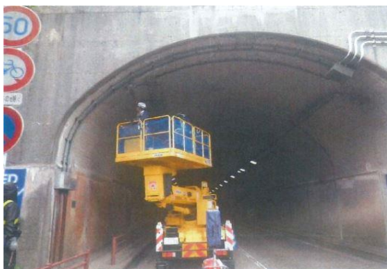
トンネル点検状況
