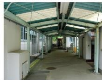
⑦管理員室、配膳室、資料室の並び。
