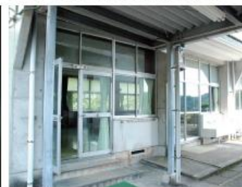
④図工室外観。
