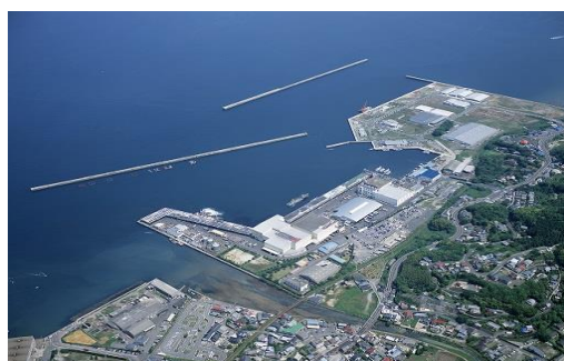
松浦火力発電所
