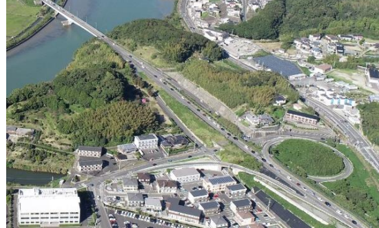
国道 205 号(未整備区間)の交通渋滞状況
