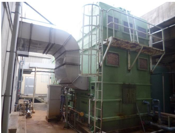
(中部下水処理場 水処理脱臭設備)
