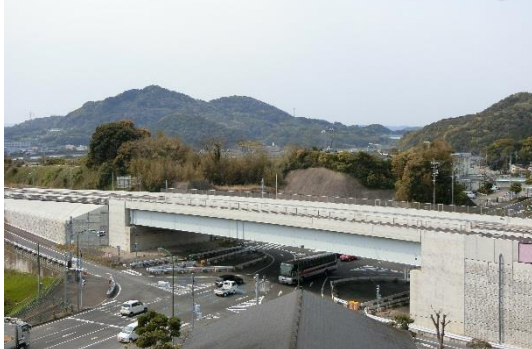
国道 205 号(江上交差点)の整備状況①
