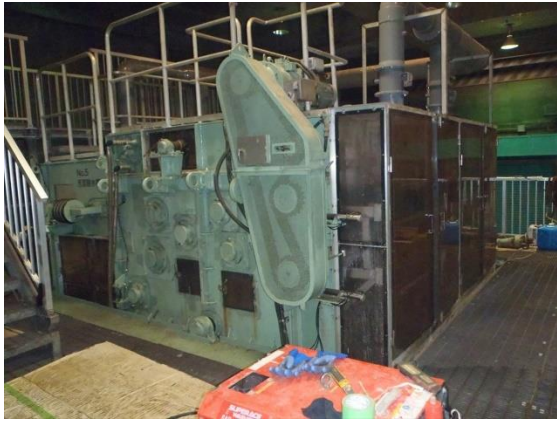
(中部下水処理場 脱水設備)
