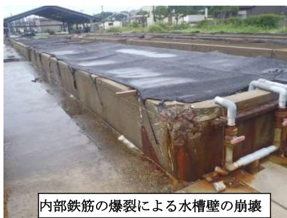
内部鉄筋の爆裂による水槽壁の崩壊
