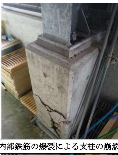
内部鉄筋の爆裂による支柱の崩壊
