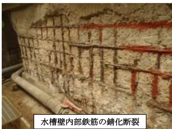
水槽壁内部鉄筋の錆化断裂
